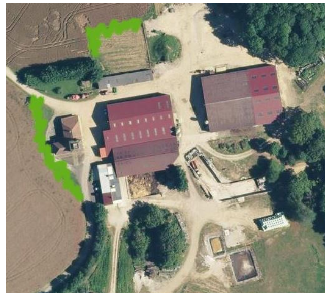
Figure 6 : Possible localisation de haies plantées sur la ferme de Gillaumont (Source : Géoportail et BE Jacquel et Chatillon)
